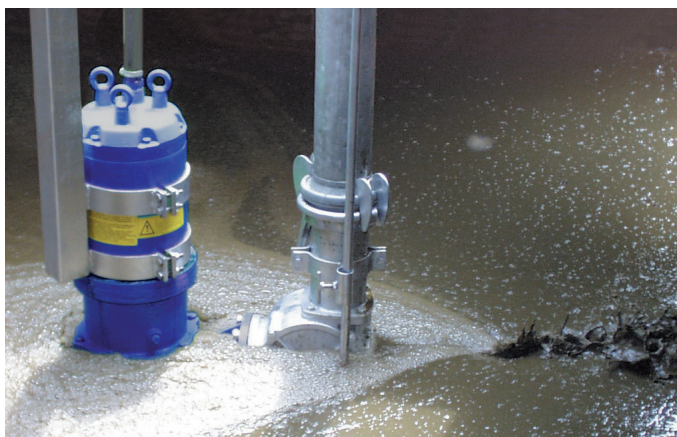
Загрузка установки специальным погружным насосом с измельчителем
